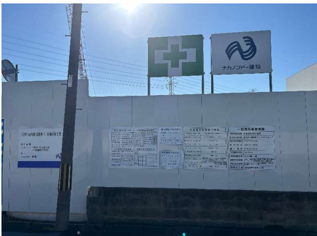
ゲート看板設置状況
