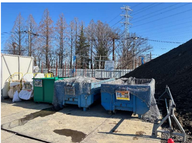
ゴミ置場設置状況
