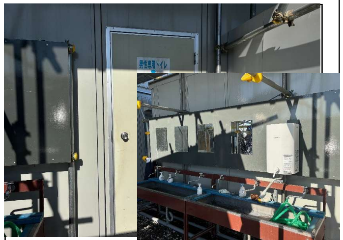
トイレ設置状況
