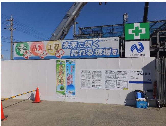
ゲート看板設置状況
