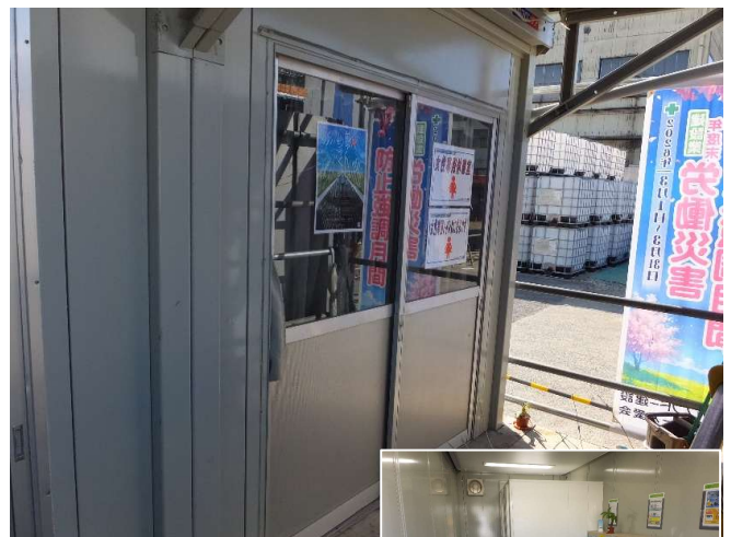
トイレ設置状況
