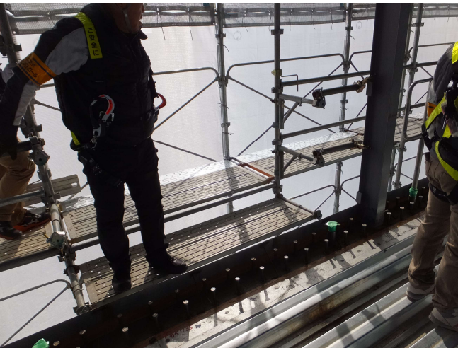
仮設足場 手摺設置状況
