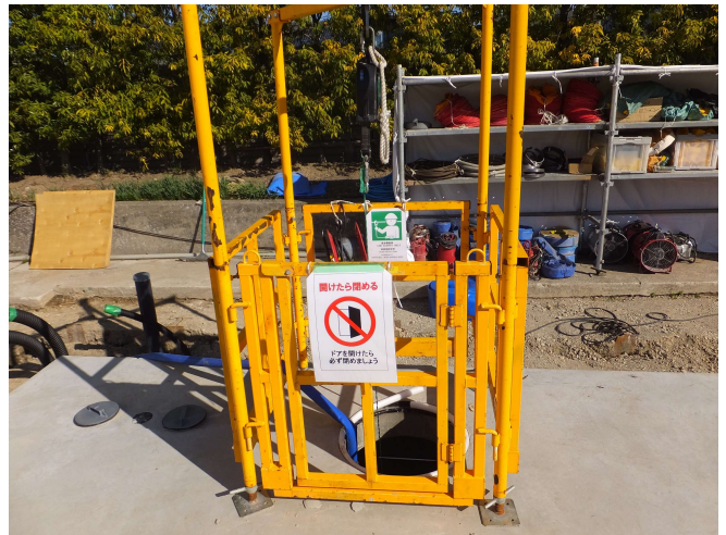
開口部 墜落防止設備設置
