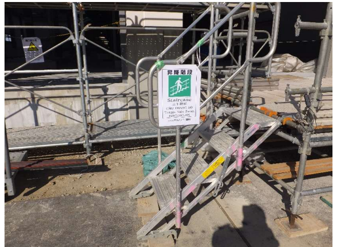
安全標識設置状況
