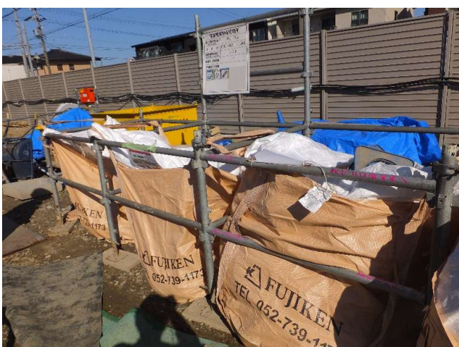
ゴミ置場設置状況
